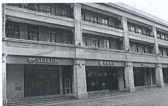
外墙设置情形
