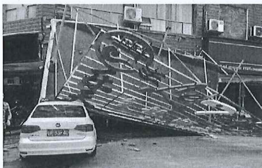
利用违法构筑物设置造成房屋安全事故的情形
